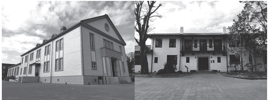
耐震工事後の講堂と陵水会館
